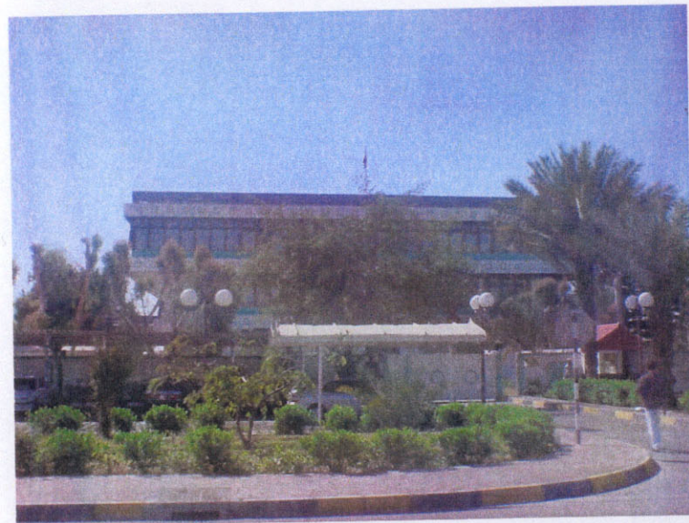
صورة تظهر مدخل المراجعين وواجهة السفارة الرئيسية
